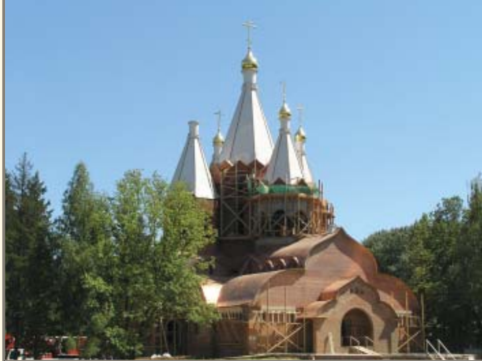
Строящийся соборный храм. 2005 г.
