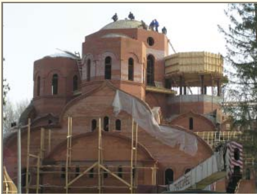
Строящийся соборный храм. 2005 г.
