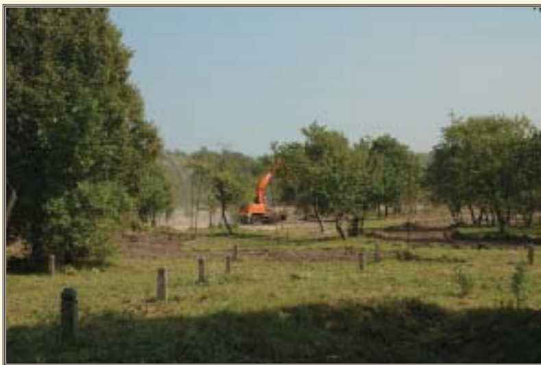
Работы по благоустройству территории Бутовского полигона. 2005 г.
